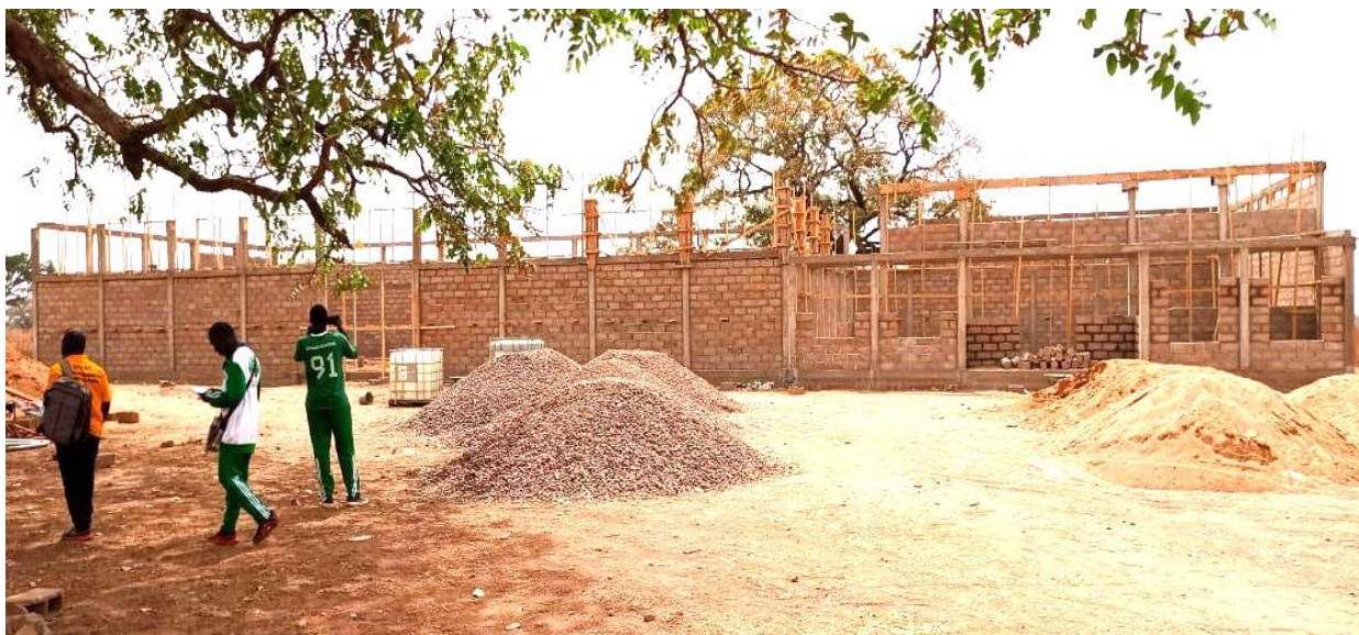
Photo 4 : Magasin de stockage en cours de construction financé par PADFA II – Coopérative RISKOU MARORI, Mapto
